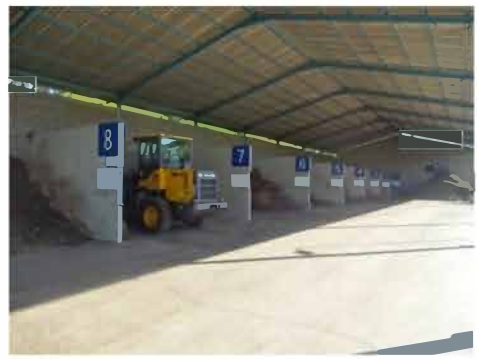
インドネシア・スラバヤ市に設置・稼働した 生ごみの堆肥化施設(当時)
